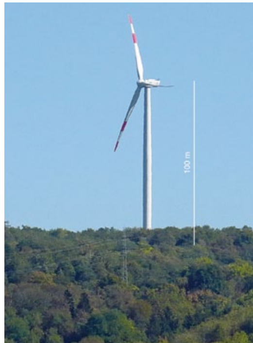
Abbildung 1. Die Windenergieanlage (WEA) auf dem Gelände des Fraunhofer-Instituts für Chemische Technologie in Pfinztal (ICT) vom Silzberg, dem Standort des manuellen Lichtfangs (mLF) aus gesehen. Sie gehört mit 100 m Nabenhöhe und 82 m Rotordurchmesser zur dominierenden dreiblättrigen Bauform. Mit ihren 2 Megawatt (MW) Leistung rangiert sie im unteren Leistungsbereich heute gängiger Onshore-Anlagen. Sie wurde für das ICT errichtet, um die Zwischenspeicherung der mit der WEA erzeugten elektrischen Energie in einer Redox-Flow-Batterie mit einem Endausbau von 20 MWh Kapazität zu testen. – Foto: R. MÖRTER.
