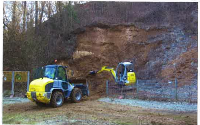
Abb. 2: Arbeit mit schwerem Gerät.
