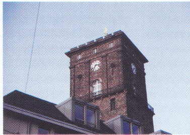
Abbildung 6 Rathausurm in Karlsruhe. Das Mauerwerk besteht hauptsächlich aus den Bruchsteinen des Bausandsteins aus den Steinbrüchen im Pfinztal.
