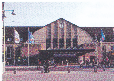
Abbildung 8 Karlsruhe Hauptbahnhof. Für das 1913 fertiggestellte Gebäude wurde, wie an vielen Altbauten in Karlsruhe, der gelbliche Schilfsandstein gebraucht.
