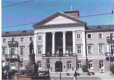
Abbildung 5 Rathaus der Stadt Karlsruhe. Die Treppe zum Eingang und die Bodenplatten auf dem Marktplatz davor sind aus Bühlertal-Granit gefertigt.
